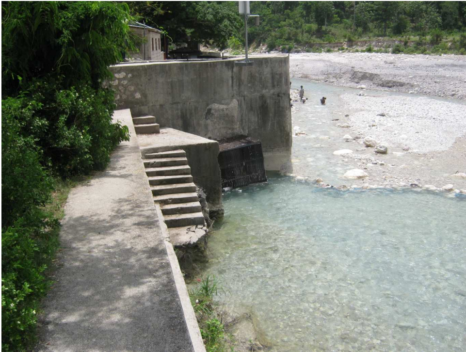
Photo 7.4 Site de La Prise du canal d'Avezac sur la Ravine du Sud dans le secteur de Bas Camp-Perrin
