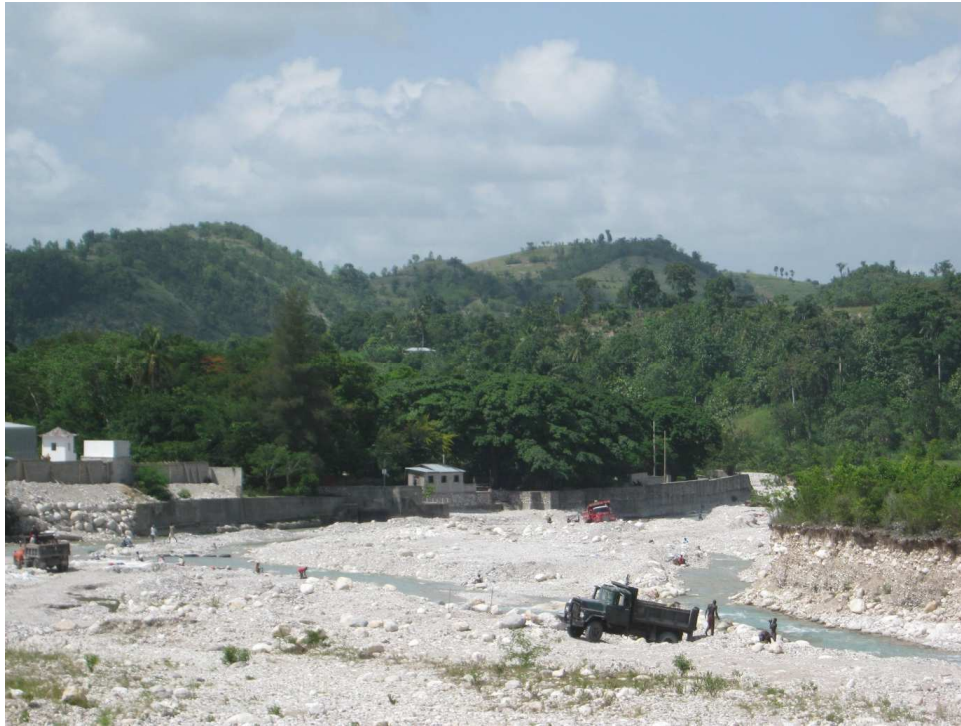
Photo 7.5 Talus d'érosion en rive gauche et mur de protection contre les inondations en rive droite à la hauteur de la localité de Bas Camp-Perrin - Août 2013
