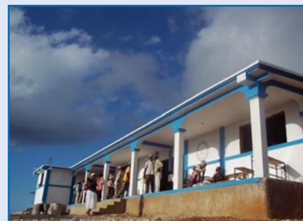
Les communautés participent à la reconstruction des infrastructures publiques © FLM, 2012
