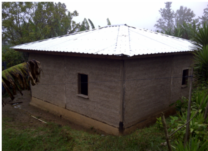
Viviendas de Nuevo Paraíso, Marale.
