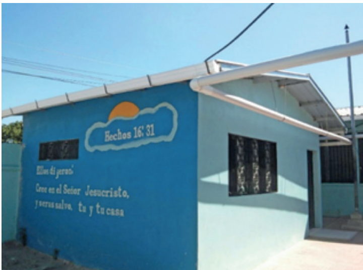
Sistema de cosecha de agua lluvia
