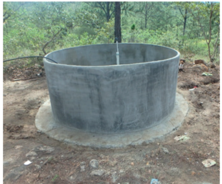
Tanque de ferrocemento en Lepaterique
