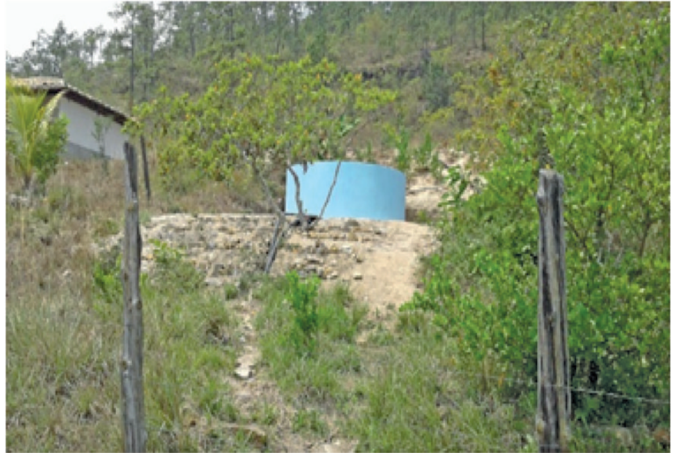
Tanque de ferrocemento en Lepaterique
