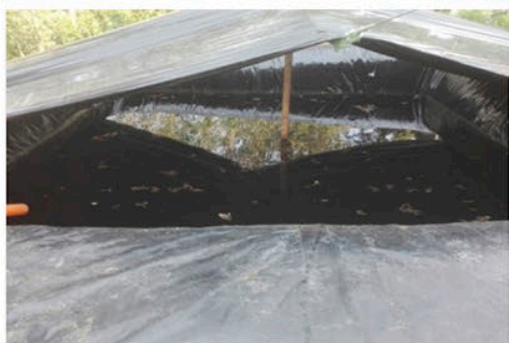
Sistema SCALL implementado en Vichibala, Cotzal. Tanque de recolección de agua colectado del techo del invernadero y tanque de distribución de agua hacia el invernadero (rotoplast), sistema de miniriego instalado. Fotografías PC-DRI - Ixil / Ambrosio Corio
