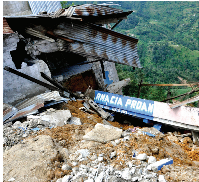
Deslizamiento en Tectitán 006, HUEHUETENANGO, Técnicos de la SE-CONRED realizaron una evaluación de riesgo en el casco urbano del municipio de Tectitán 01-10-14.
