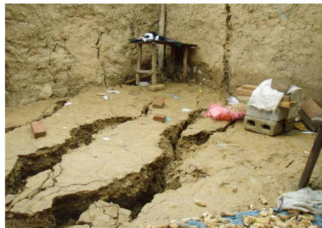
Es una abertura larga y estrecha producto de la separación de dos materiales Fuente: SE-CONRED.
