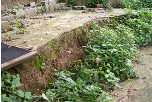
Fotografías 3 y 4: asentamiento diferencial por movimiento de masa en zona 1 de Mixco, Guatemala. Fuente: SE CONRED.
