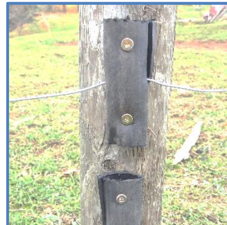
სურათი 10. რეზინის მილისგან დამზადებული თვითნაკეთი იზოლატორი
