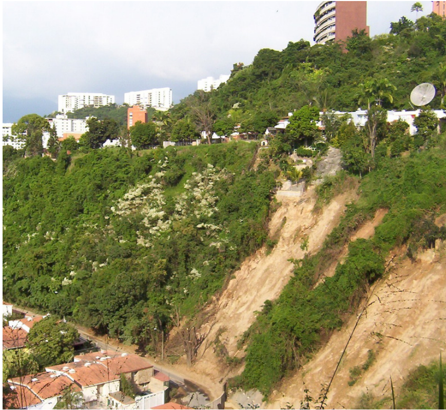
Foto 1: La urbanización de Santa Inés, al pie de un relleno de más de 30 metros de material no consolidado que no se puede anclar con pilares de hormigón armado.
