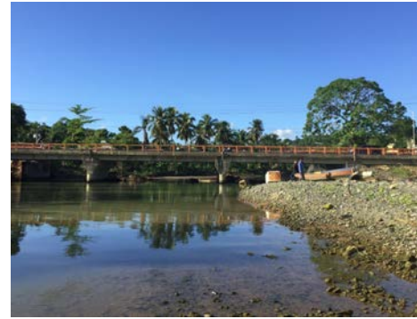
Puente sobre el río La Yeguada, Miches. Foto 21.
