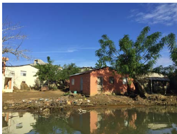
Viviendas localizadas en la zona de inundación del río La Yeguada . Foto 17.
