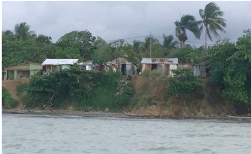
Sector Los Mameyes en Miches, expuesta a socavamientos producto del cambio de mareas. Foto 24.
