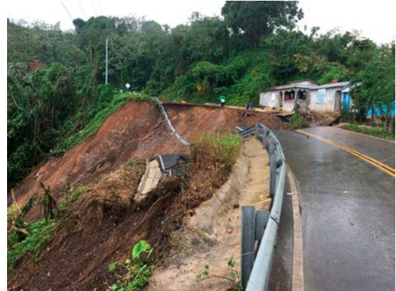
Km 10 de la vía de la provincia de El Seibo, Miches. Foto 35.
