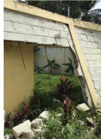
Muro perimetral. Foto 30.
