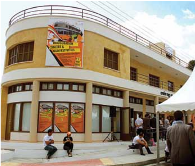
BM Ara Bölgesi'nde tamamen restore edilen Dayanışma Evi.
