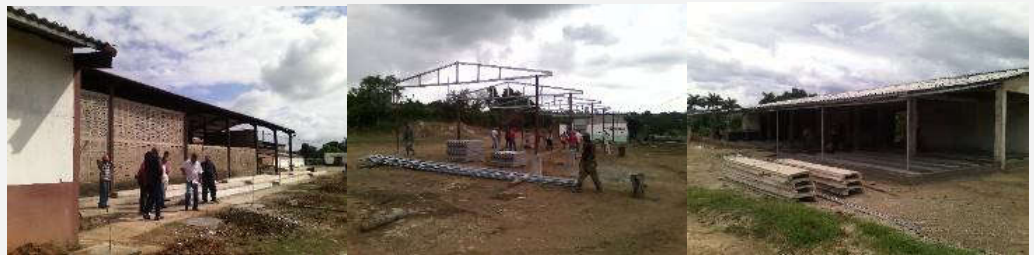
Construcción de naves y moldes para producir losa canal: Palma Soriano, San Luis y Songo La Maya
