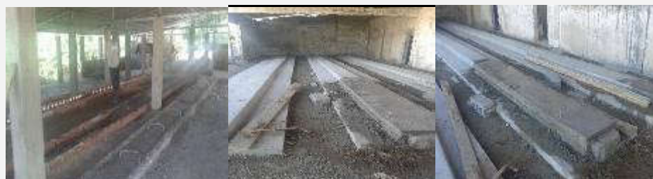
Producción de losa canal en Songo La Maya/ Producción de losa canal en San Luis
