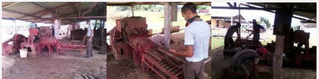
Producción de ladrillos de barro en Palma Soriano con extrusora reparada por el
