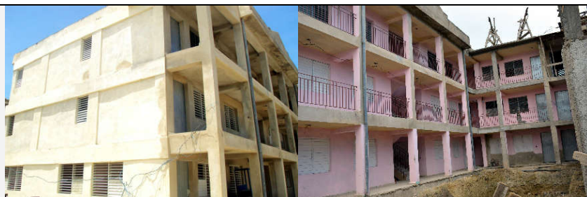
Perspectiva antes de la obra (arriba) proyecto de obra, y final de la obra del conjunto de viviendas de la Casa Rosada
