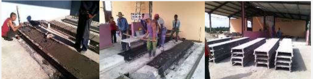
Elaboración, izaje y almacenaje de la losa canal
