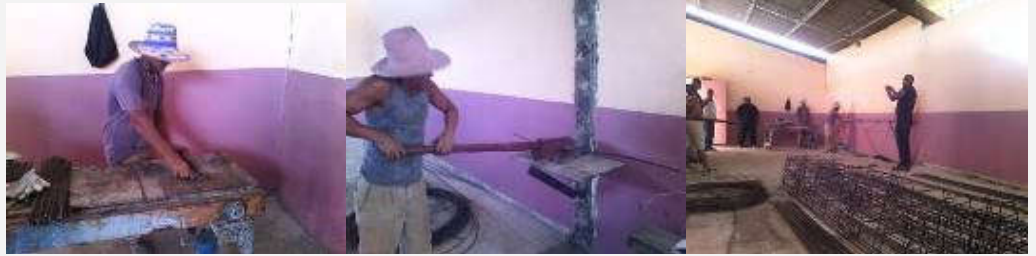
Preparación de refuerzo aceros para elaboración de losa canal: Uso de la cizalla construida por innovador local, en el marco del proyecto
