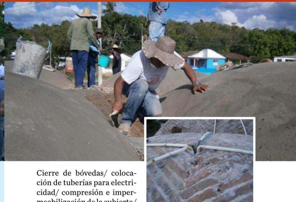
Cierre de bóvedas/ colocación de tuberías para electricidad/ compresión e impermeabilización de la cubierta/ masilla y pintura exterior/fin de las bóvedas.
