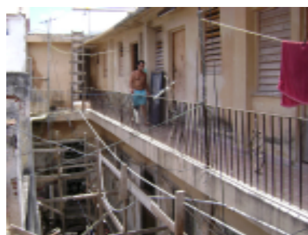
Rehabilitación del tercer nivel. Sustitución de cubierta. Rehabilitación capital incluyendo la galería
