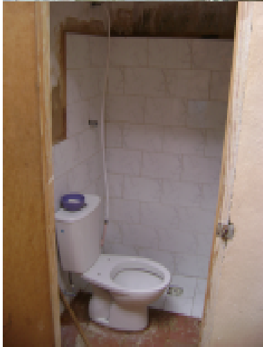
Baño colectivo antes y después de la intervención
