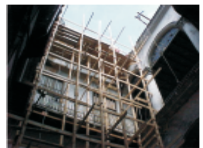
Intervención en galerías: Cuba 759
