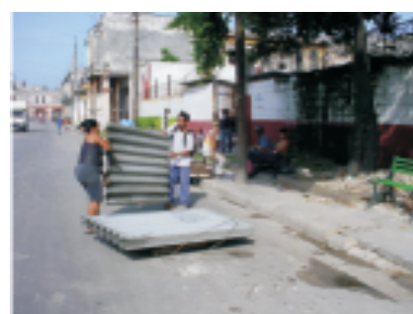
Participación de vecinos en acarreo de materiales y en las labores de construcción de una comunidad de tránsito
