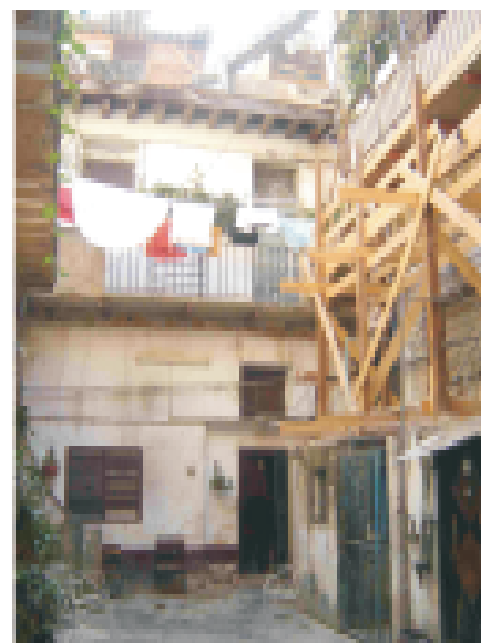
Interior de Paula 205 durante la etapa de ejecución de acciones constructivas emergentes
