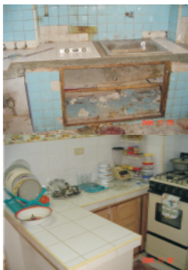
Baños y cocina, antes y después de la intervención
