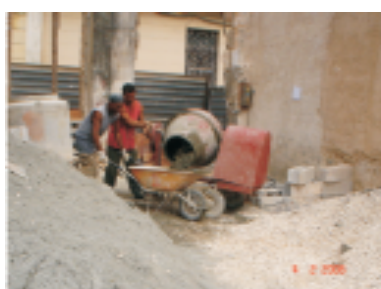
Reciclaje de viejos edificios en proyectos de interés social. Construcción de viviendas protegidas para adultos mayores concluido en abril 2008. Paula #109-111
