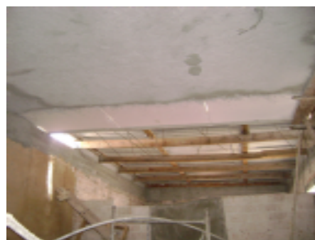
Sustitución de cubierta ligera por losa de hormigón en el tercer nivel
