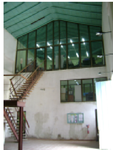
Interior de la edificación ocupada por el equipo técnico del Programa de San Isidro
