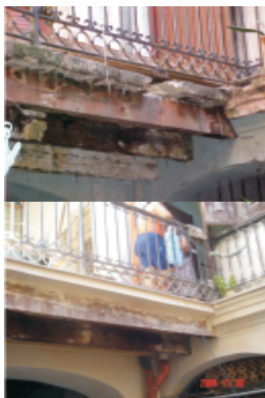
Galerías de circulación antes y después de la intervención
