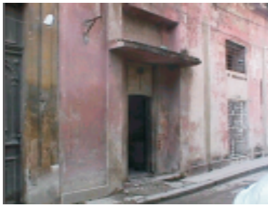
Fachada de Paula 205. Los alcances del proyecto de acciones primarias emergentes proponen remodelaciones que le devuelven al edificio una nueva imagen urbana
