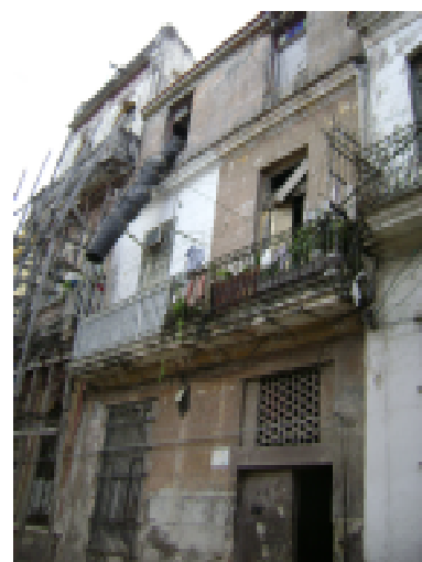
Fachada de Revillagigedo 158 antes y durante la intervención
