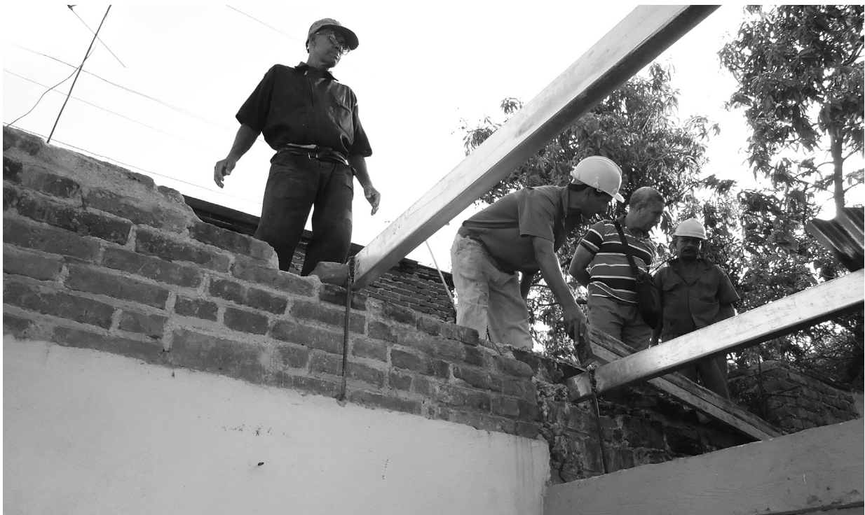
MONTAJE PILOTO PARA EVALUAR LOS CONOCIMIENTOS ADQUIRIDOS EN LAS CAPACITACIONES TÉCNICAS DE COLOCACIÓN DE CUBIERTAS.
