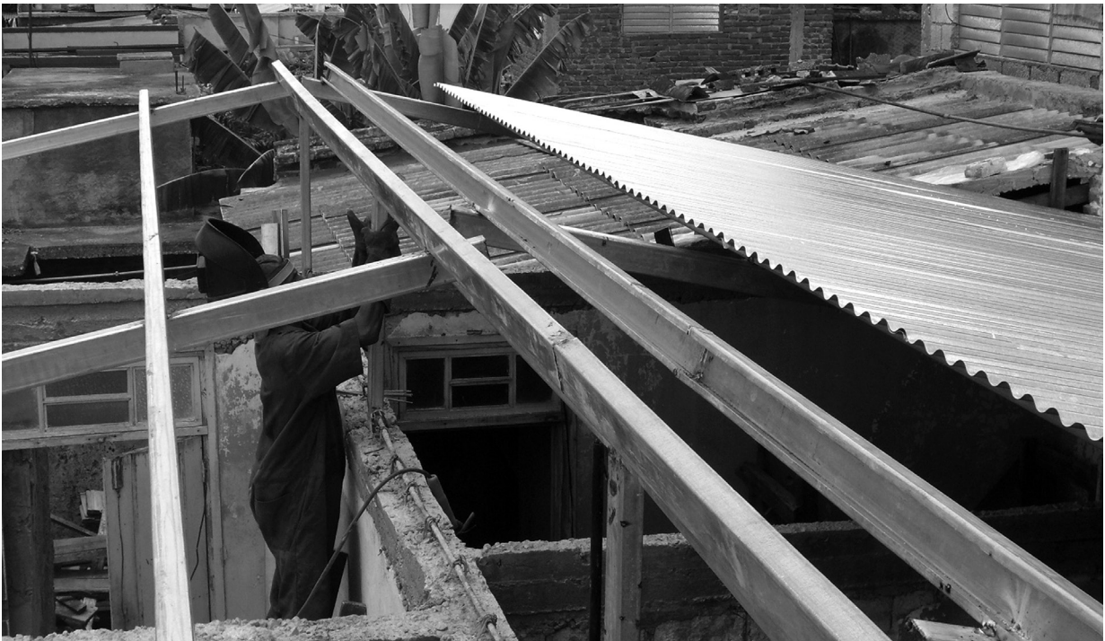
REPOSICIÓN DE CUBIERTAS A FAMILIAS SOCIALMENTE VULNERABLES COMO PRIMERA ACCIÓN DEL PROYECTO DE RECUPERACIÓN TRAS EL PASO DEL HURACÁN SANDY.
