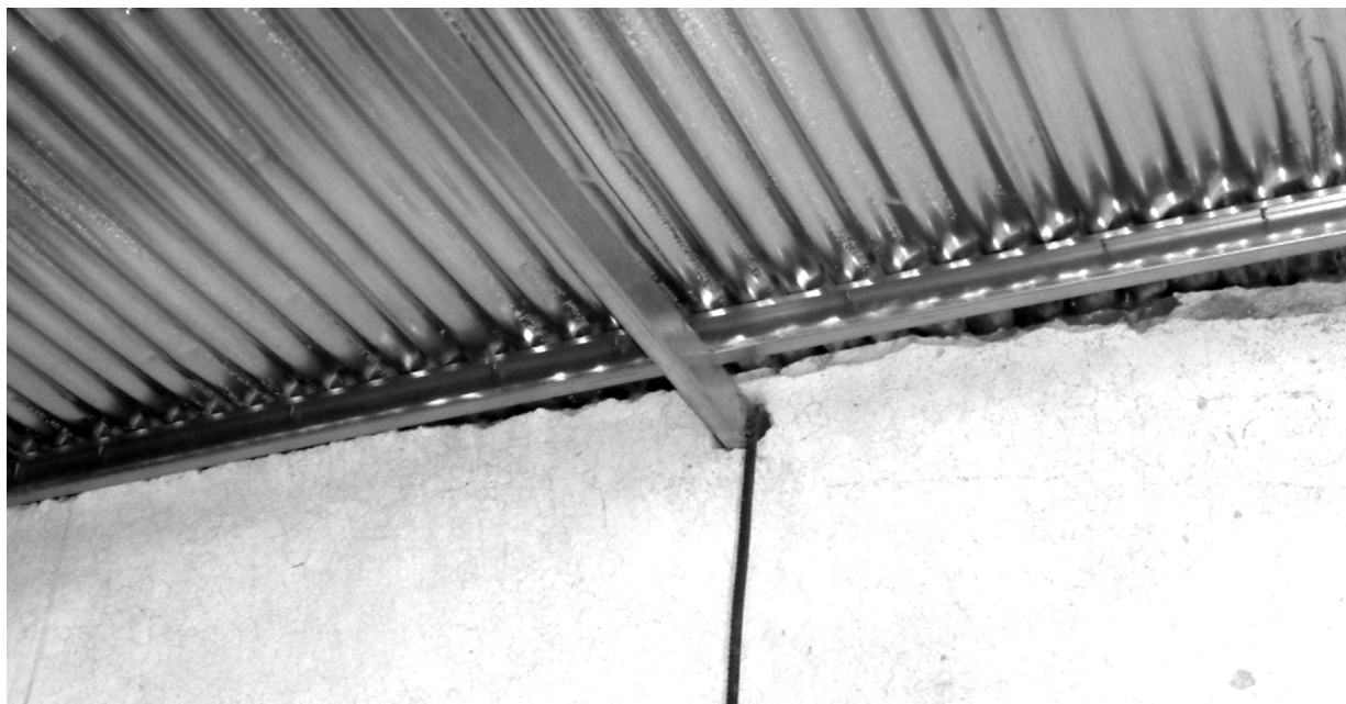
SOLUCIÓN TÉCNICA DADA POR LA UNIDAD INVERSIONISTA DE LA VIVIENDA DEL MUNICIPIO PALMA SORIANO: MONTAJE DE ESTRUCTURAS METÁLICAS EN CUBIERTAS DE VIVIENDAS SIN CERRAMIENTO SUPERIOR PARA BENEFICIAR A UN MAYOR NÚMERO DE FAMILIAS EN LA ETAPA DE EMERGENCIA.
