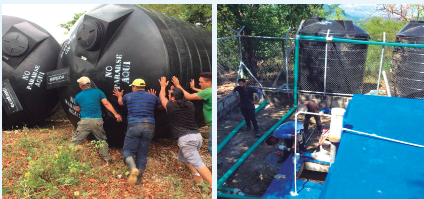
Figura 2. Instalación de dos tanques en la ASADA Corralillo de Nicoya.
