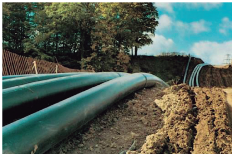
Figura 2. Detalle de tubería PEAD.
