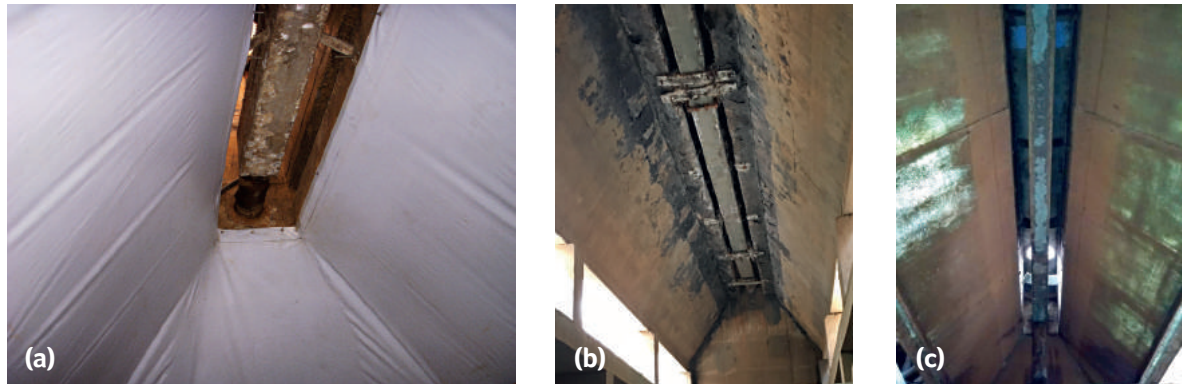
Figura 12 – Separadores trifásicos con canaleta interna de colecta de nata: a) STF confeccionado en concreto y lona, con canaleta en aluminio; b) STF confeccionado en concreto, con canaleta en PRFV; c) STF confeccionado en PRFV, con canaleta en PRFV.
