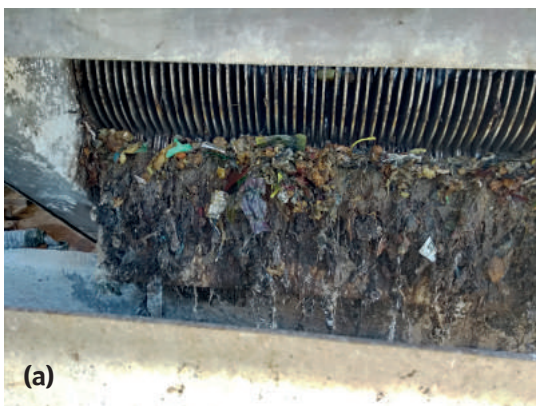
Figura 5 – a) Sólidos retenidos en una unidad de tamizado de 6mm; b) presencia de sólidos en lodo y en nata deshidratada en lechos de secado.
