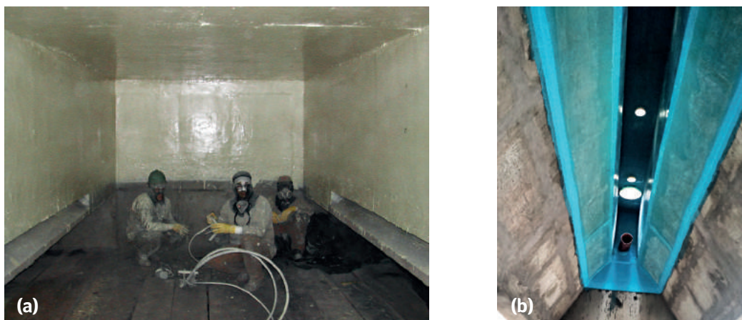
Figura 9 – Revestimiento interno de reactores UASB: a) aplicación de Polibrid; b) aplicación de PRFV.
