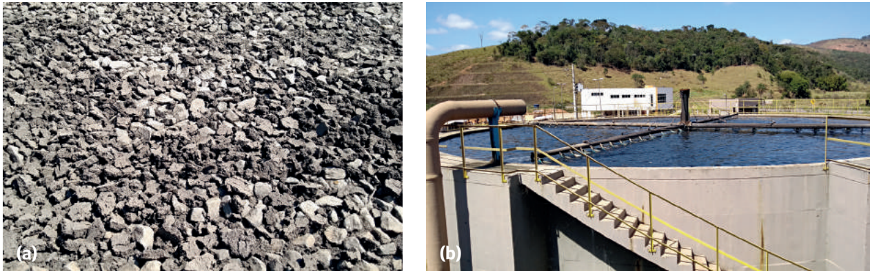
Figura 1 – Impacto de la pérdida excesiva de sólidos sobre la unidad de postratamiento: a) colmatación del medio de soporte; b) inundación de filtros biológicos percoladores post-reactores UASB.
