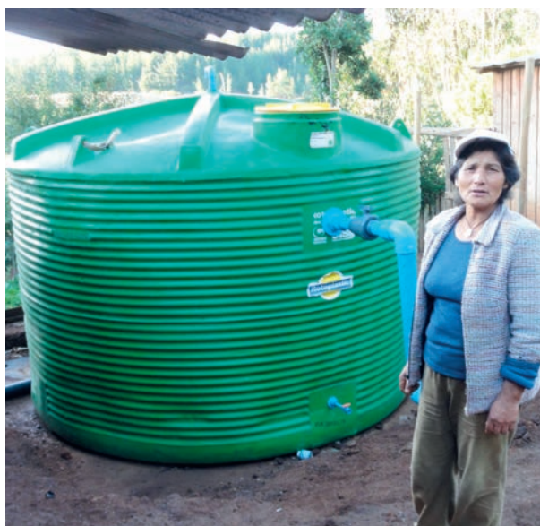
Estanque de polietileno con capacidad de 20 metros cúbicos. (Fuente: Roberto Pizarro, Universidad de Talca).
