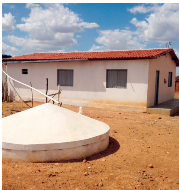
Cisterna con superficie de captación en tejado, Brasil. (Fuente: Milcíades Gadelha de Lima, Fundación Agente).
