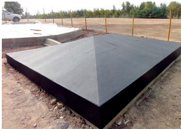
Sistema de captación y almacenamiento de agua de lluvia para consumo humano. (Fuente: Roberto Pizarro, Universidad de Talca).
