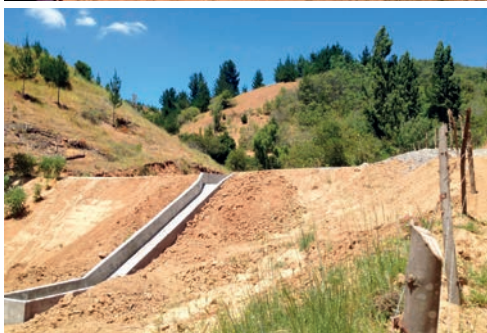
Captación de agua de lluvia superficial y almacenamiento en tranques. A la derecha, detalle de canalización del agua que evita la erosión de las paredes del tranque. (Fuente: Homero Barría, INDAP).
