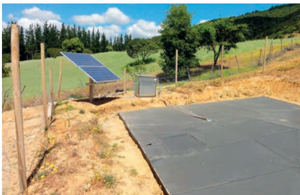
Sistema de captación y almacenamiento de agua de lluvia para consumo humano. (Fuente: Roberto Pizarro, Universidad de Talca).
