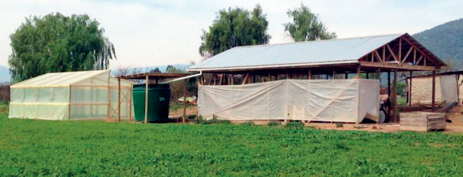
Sistema de captación de agua de lluvia desde los techos para el riego de un invernadero de 40 metros cuadrados en la Región de O'Higgins. (Fuente: Homero Barría, INDAP).
