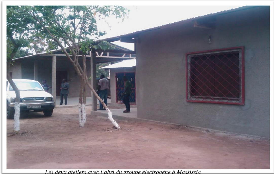
Les deux ateliers avec l'abri du groupe électrogène à Massissia
