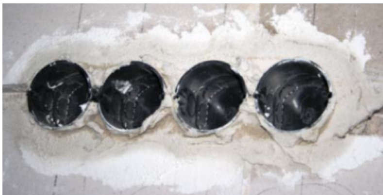
Рис. 25. Герметичная установка розеток в незастывшую шпатлевку [8].
