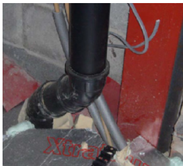
Рис. 24. Пример неправильного планирования и незнания о проблеме герметичности [8].
