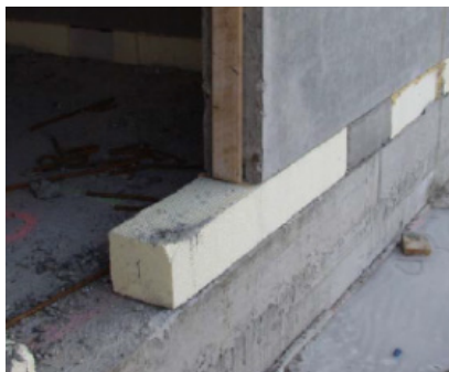
Рис. 11. Гибридный терморазрыв, использованный в кирпичном многоквартирном доме [8].
