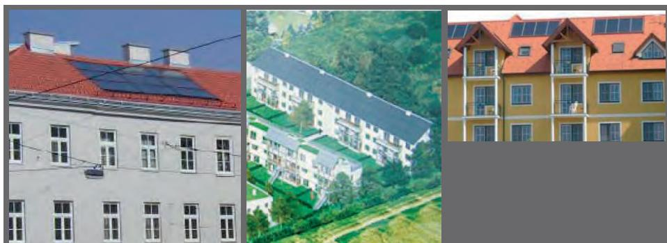
Рис.3. Варианты расположения коллекторов на наклонной крыше.
