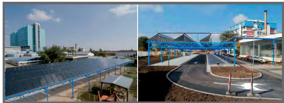
*Рис.5. Общий вид тепловых гелиоколлекторов, размещаемых на специальной металлоконструкции в непосредственной близости от здания.*
