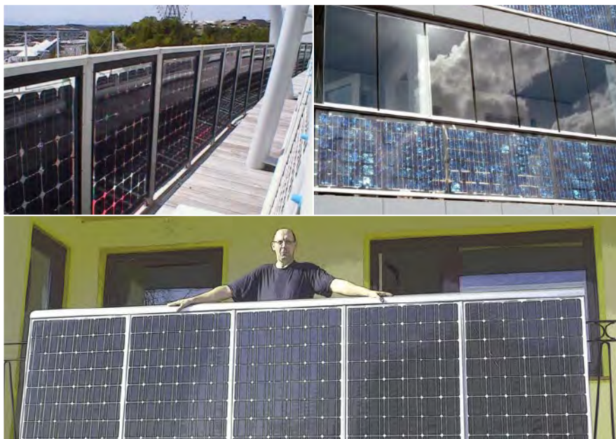
Рис. 10. Установка солнечных панелей на балконах и лоджиях
