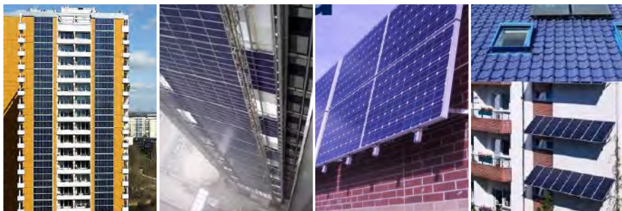
Рис. 11. Установка солнечных панелей на стене зданий
