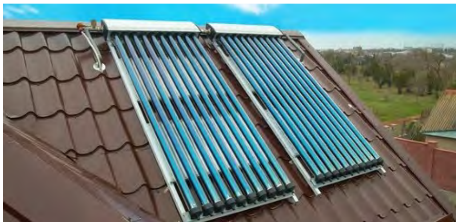
Рис. 7. Солнечные вакуумные коллекторы на крыше дома
