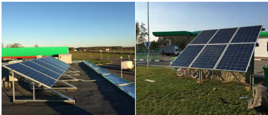
Рис. 2. Установка солнечных панелей для pv-системы нагрева воды
