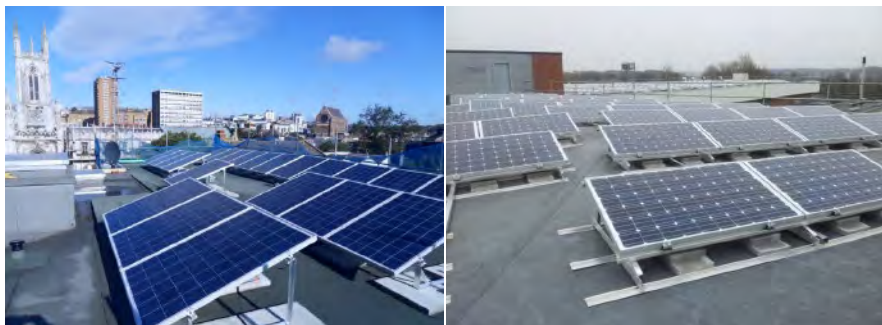
Рис. 8. Установка солнечных панелей на плоской крыше
