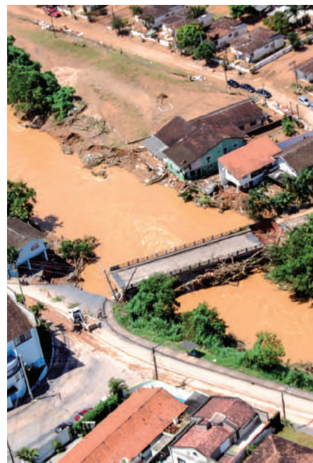
Foto: Defesa Civil
