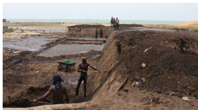
Des ouvriers à l'œuvre dans le bassin d'épuration
