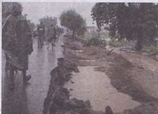
Figure 7.1 et 7.2 : Effets d'affouillement sur l'avenue du Yatenga et la digue latérale du barrage n° 3 de Ouagadougou des suites d'une pluie de 263 mm tombée le 1 er septembre 2009
