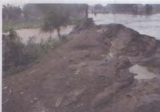
Figure 7.1 et 7.2 : Effets d'affouillement sur l'avenue du Yatenga et la digue latérale du barrage n° 3 de Ouagadougou des suites d'une pluie de 263 mm tombée le 1 er septembre 2009
