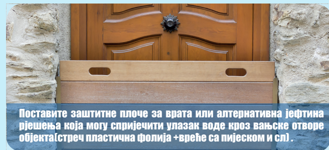
Поставите привремене баријере око објекта (раније припремљене), вреће за пијесак пунити само до пола, слагати по принципу зида од цигли!
