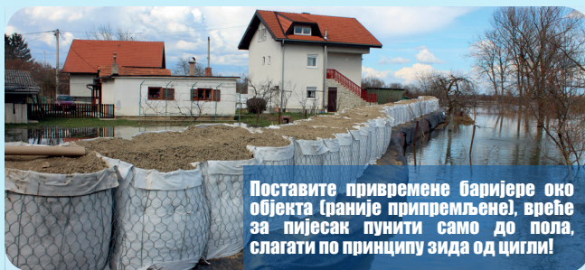
Поставите заштитне плоче за врата или алтернативна јефтина рјешења која могу спријечити улазак воде кроз вањске отворе објекта (стреч пластична фолија + вреће са пијеском и сл.).
