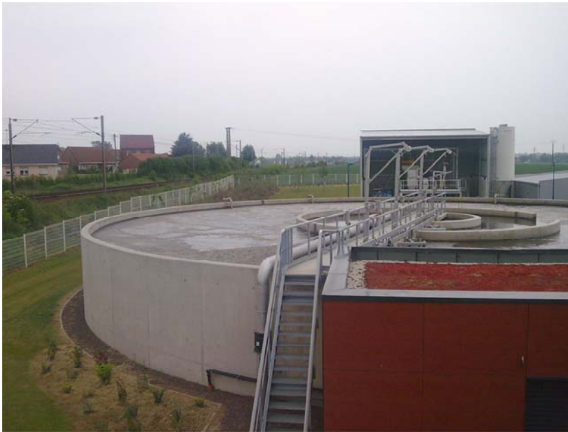
Slika 5.2 Postrojenje za prečišćavanje otpadnih voda blizu Lille-a, Francuska
