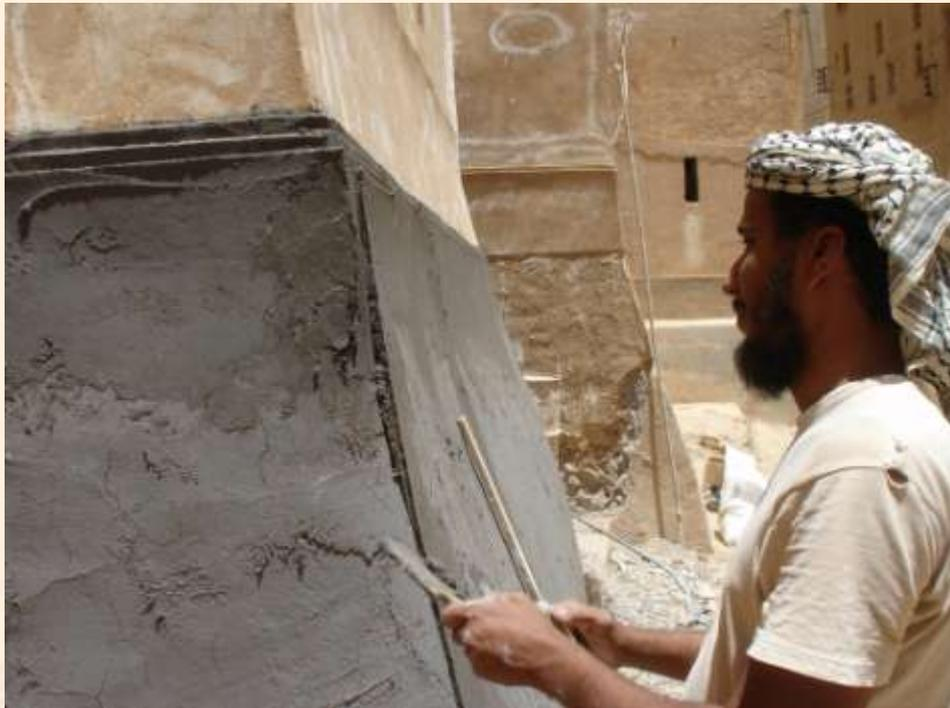
شكل ٣-١٧: استخدام الرماد في تلبيس الجدار الخارجي للمبنى الطيني (الحمش)
