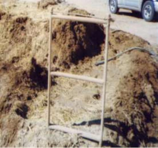
شكل ٣-٩: قالب صناعة المدر (المفتل)
