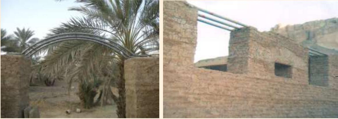
شكل ٤-١٤: عمل العتبات (التياسير) بالأنابيب الحديدية
