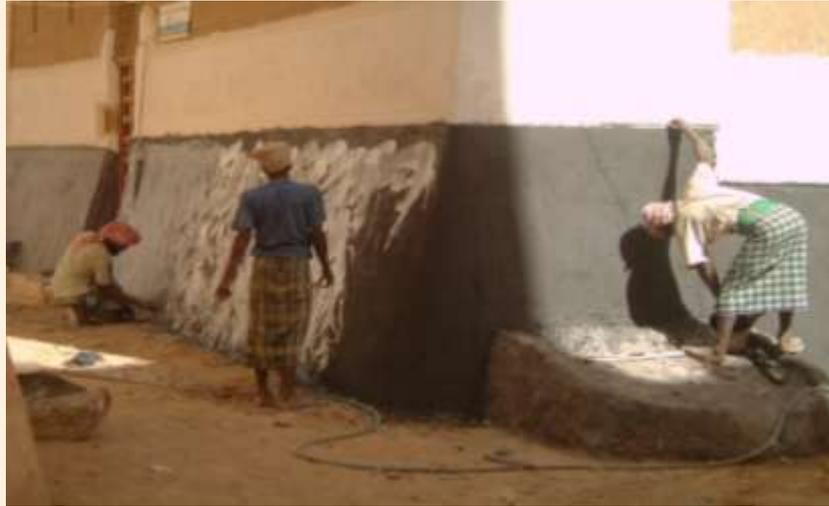
شكل ٤-٢٤: صيانة المباني القائمة بعمل لياسته بالرماد لكرسي المبنى (الحمث)
