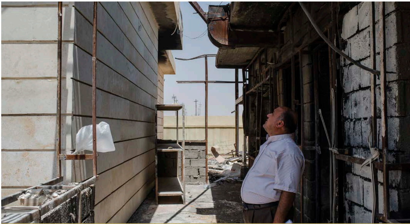
مهندس يقارن مبنى بعد إعادة تأهيله (يساراً) باخر لم يخضع للإصلاح بعد في مستشفى الحمدانية. تم الحصول على الحجر الجيري المستخدم في تغطية المبنى الجديد محلياً. © برنامج الأمم المتحدة الإنمائي في العراق/ أليكس بوتر
