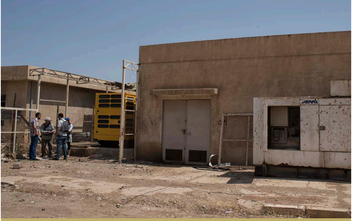
مولّد جديد (يساراً) في جامعة الموصل يحل محل مولد معطوب (يميناً). تم بالفعل توريد 8 مولدات، مما يساعد على إمداد المؤسسة بالكهرباء فيما يؤدي الطلاب امتحاناتهم. © برنامج الأمم المتحدة الإنمائي في العراق/ ماكنزي
