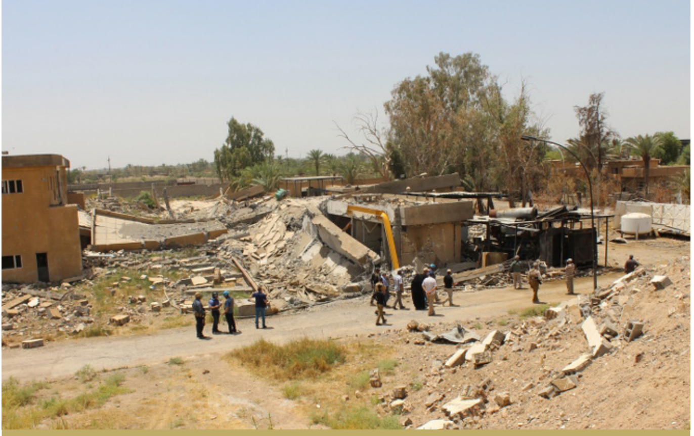
محطة الأزرقيّة لمعالجة المياه قبل إعادة تأهيلها في أغسطس/آب 2016. © برنامج الأمم المتحدة الإنمائي في العراق
