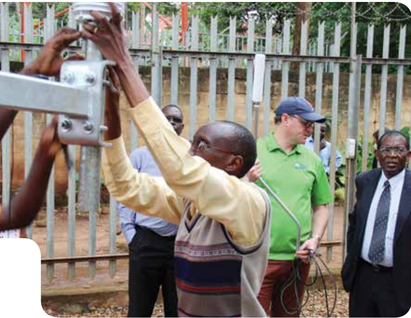
INSTALLATION D'UN SYSTÈME DE DÉTECTION DE LA Foudre EN OUGANDA.
