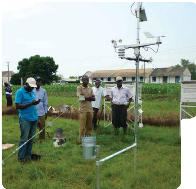
INSTALLATION D'UNE STATION MÉTÉOROLOGIQUE AUTOMATIQUE.
