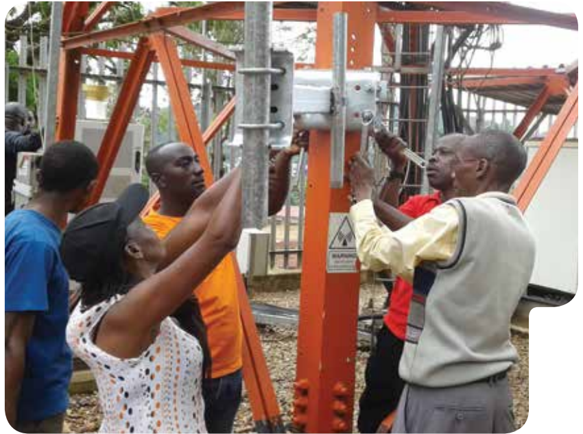
PRÉPARATION D'UNE SMA EN VUE DE SON INSTALLATION SUR UNE ANTENNE-RELAIS EN OUGANDA. UN CAPTEUR DE DÉTECTION DE LA Foudre SERA ÉGALEMENT INSTALLÉ. AFIN D'AUGMENTER LA PROBABILITÉ DE LOCALISER CORRECTEMENT LES IMPACTS DE Foudre, LE SYSTÈME DE LOCALISATION DE LA Foudre INTÉGRERA DES DONNÉES ISSUES DES RÉSEAUX DES PAYS VOISINS (BURUNDI, KENYA ET TANZANIE), PERMETTANT AINSI D'AMÉLIORER LA COOPÉRATION RÉGIONALE EN MATIÈRE DE SYSTÈMES D'ALERTE PRÉCOCES. CRÉDIT PHOTO : SOLOMON MANGENI
