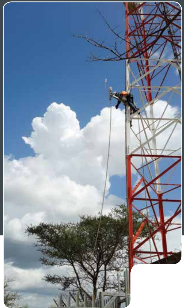
INSTALLATION D'UNE STATION MÉTÉOROLOGIQUE AUTOMATIQUE TOUT-EN-UN SUR UNE TOUR DE TRANSMISSION.
