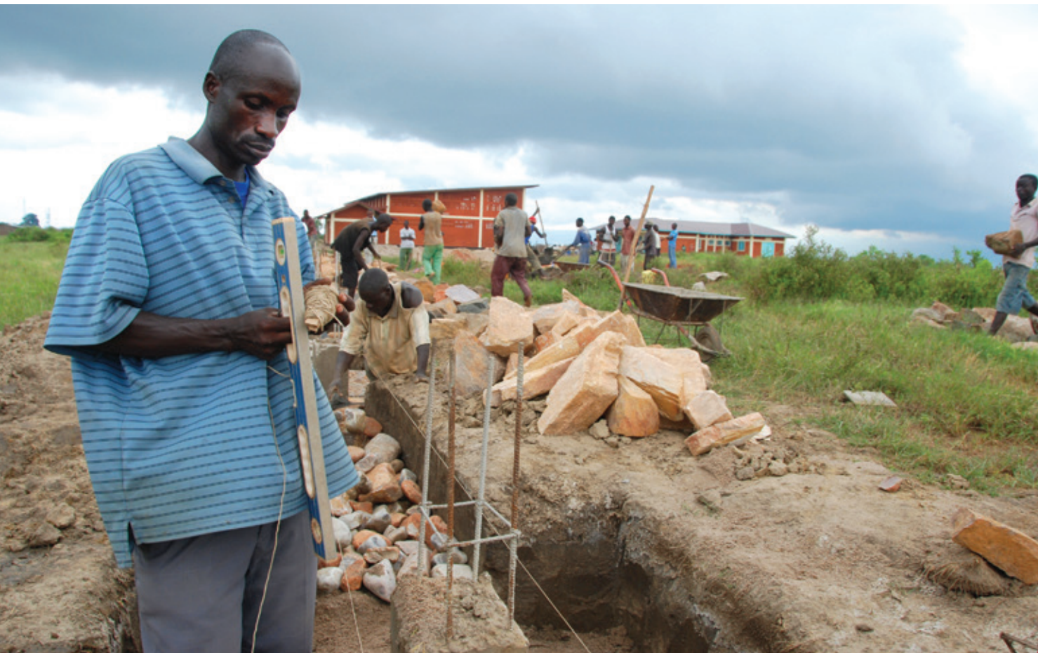
Un ouvrier se tient devant un chantier qu'il a aidé à construire. Photo : Aude Rossignol/PNUD Burundi
