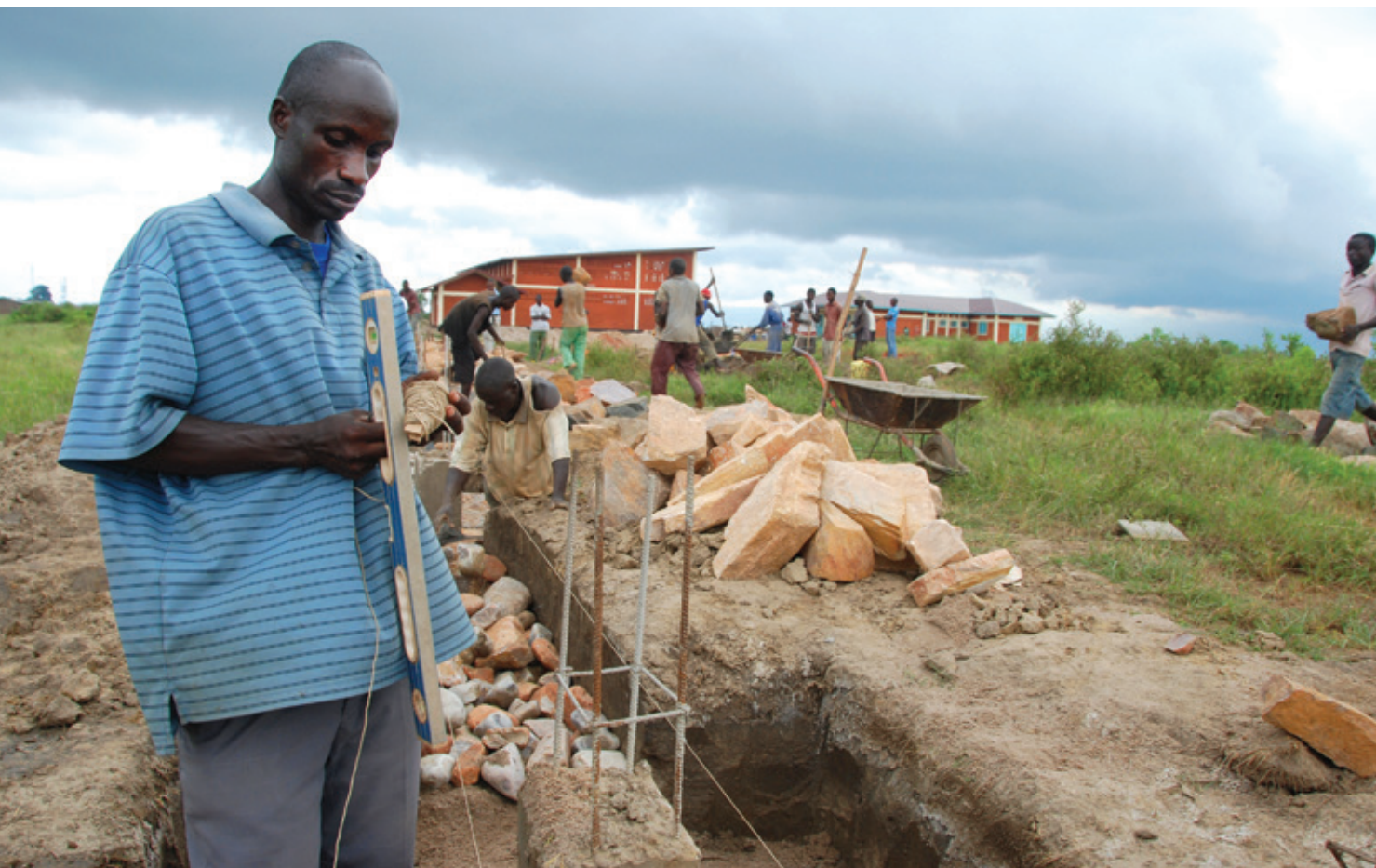
Trabajador frente a la obra de construcción en la que participó. Foto: Aude Rossignol/PNUD Burundi
