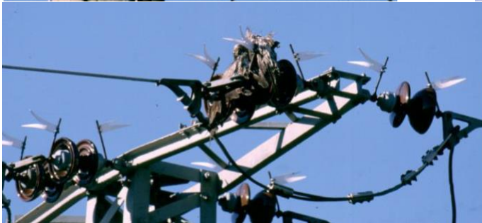
شکل 44 طرح های واقعی پایه ها که باعث میزان بلند مرگ و میر پرندگان ناشی از برق گیری می شود 99
