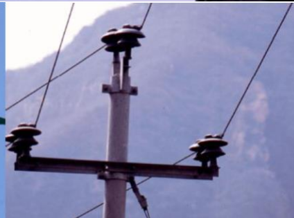
شکل 44 طرح های واقعی پایه ها که باعث میزان بلند مرگ و میر پرندگان ناشی از برق گیری می شود 99
