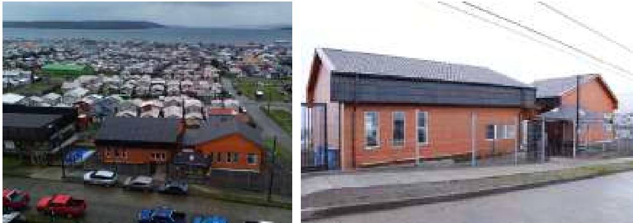
Imagen 74 y 75: Centro Comunitario de Cuidados Quellón
