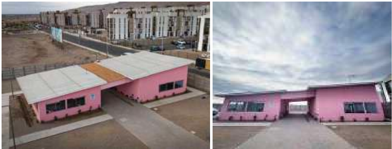
Imagen 6 y 7: Centro Comunitario de Cuidados Arica – Nuevo Norte
