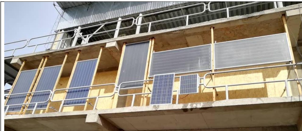
Плоские солнечные коллекторы и фотоэлектрические панели водонагревательных установок на основе технологий обратного и внешнего слива
