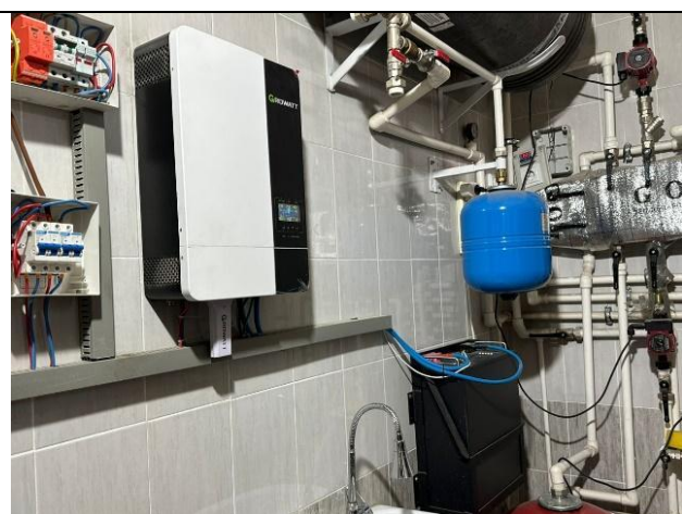
Инвертор, аккумулятор ФЭС
