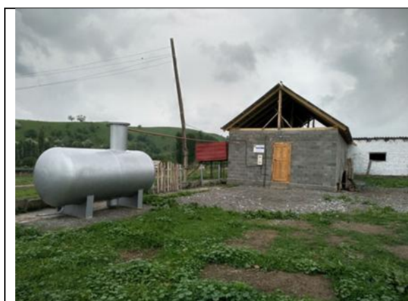
Газгольдер и здание с оборудованием биогазовой установки
