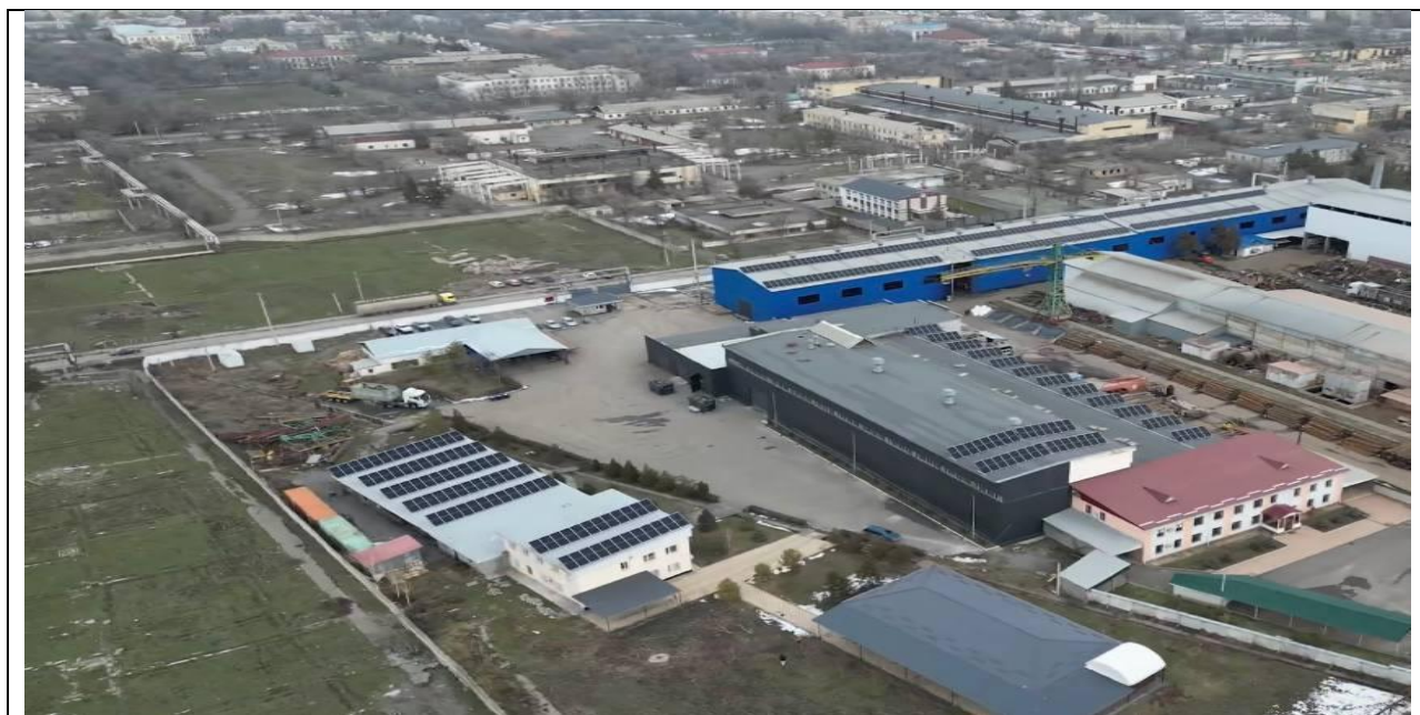
ФЭС 220 кВт в Кыргызстане, https://www.soventus-energy.com/
