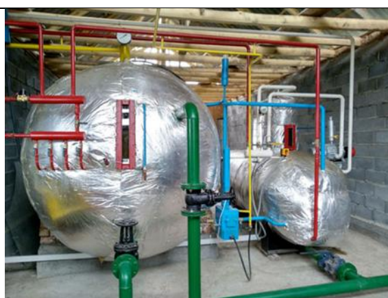
Реактор и бункер загрузки биогазовой установки
