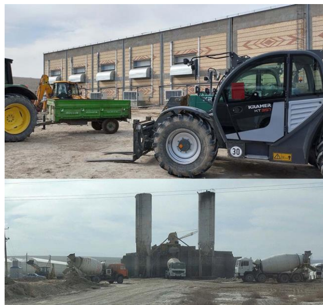
Фото 4. Завершается строительство холодильных помещений для хранения плодоовощной продукции
