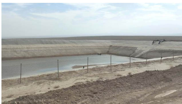
Фото 3. Водоприемник для осветления вод Каракум-реки
