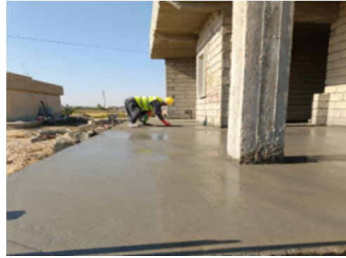
الأشغال المدنية - صب الأرضية بالاسمنت
