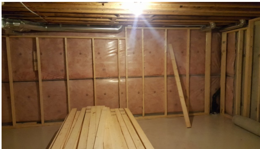
Figura 11. Izolarea termică a subsolului pe partea interioară 10
