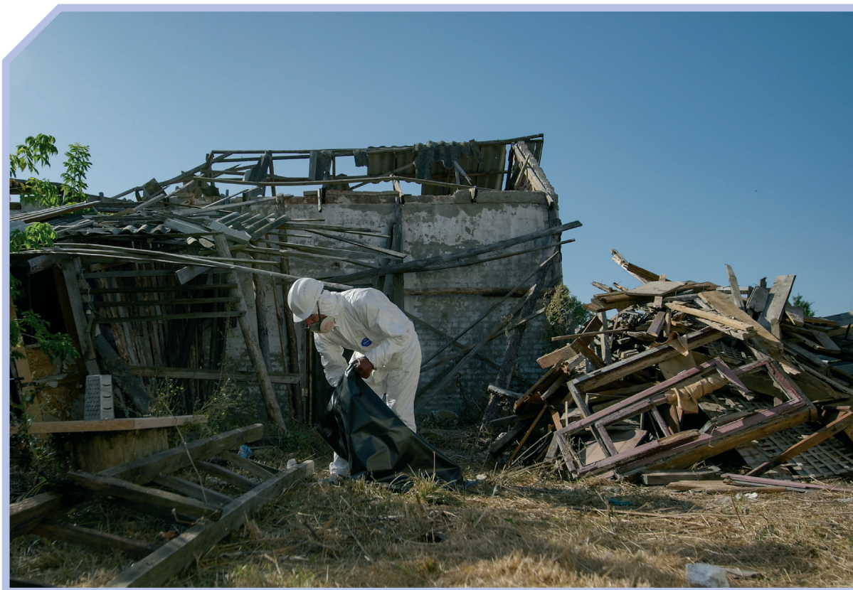
2023年8月、キーウ州で、特殊防護服を着用し、破壊された家屋の庭からアスベストを含む物質を収集するがれき撤去作業員。 写真: Nazarii Mazyliuk / UNDP Ukraine
