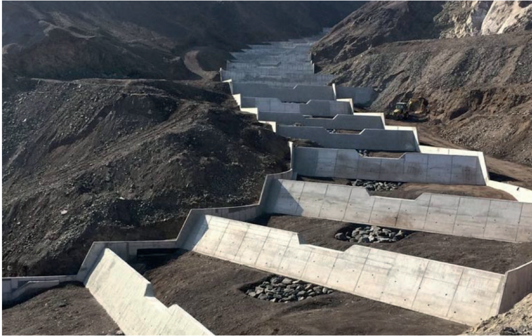
Imagen 39. Obra de control aluvional Taltal.
