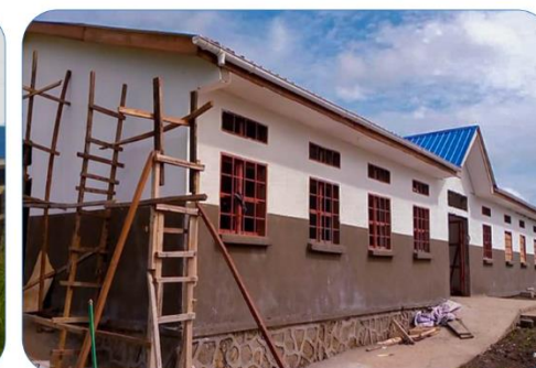
CENTRE DE SANTE MUTOWA-TERRITOIRE KALEMIE
