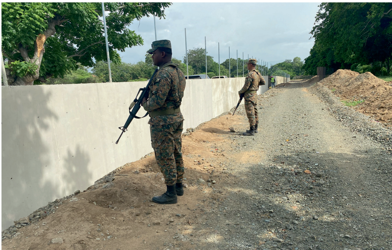
Foto de la verja inteligente perimetral en construcción.
