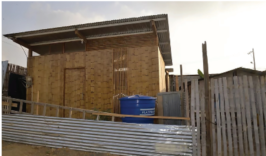
Producto final – arquetipo sostenible fabricado con ecomateriales.
