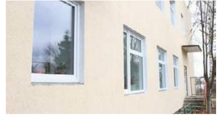
Малюнок 35. Після реконструкції
