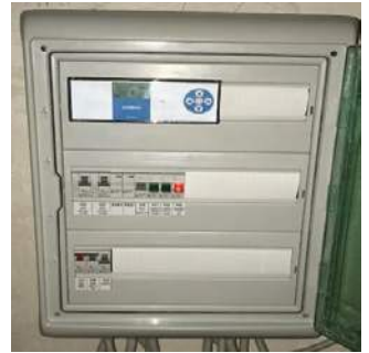
Малюнок 12. Шафа керування ІТП SynergyData
