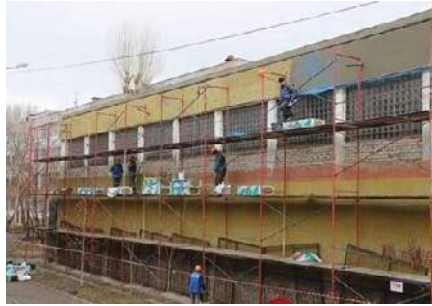
Малюнок 17. В процесі реконструкції
