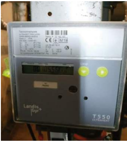
Малюнок 27. Тепловий лічильник Ultraheat
