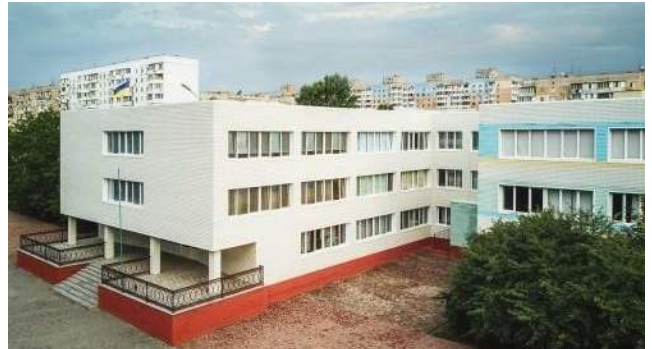
Малюнок 26. Після реконструкції
