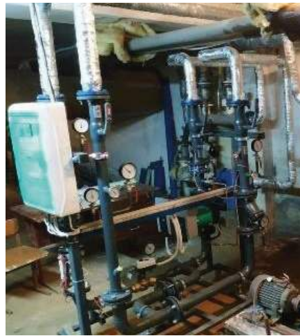
Малюнок 28. Модульний ІТП Danfoss
