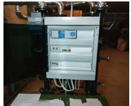
Малюнок 21. Шафа керування ІТП SynergyData
