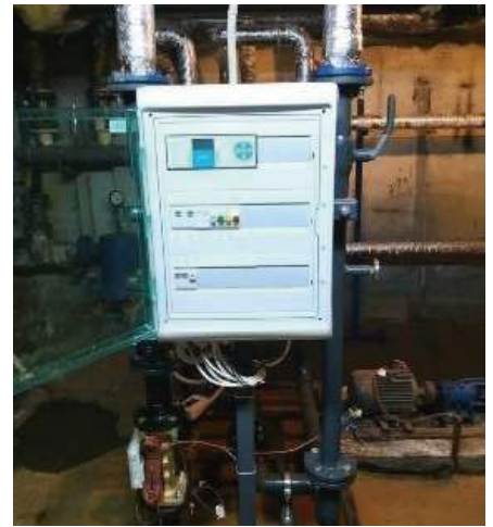
Малюнок 29. Шафа керування ІТП SynergyData
