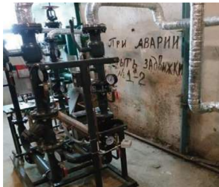
Малюнок 20. Модульний ІТП Danfoss
