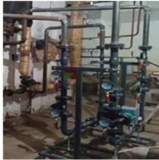
Малюнок 10. Модульний ІТП Danfoss №3
