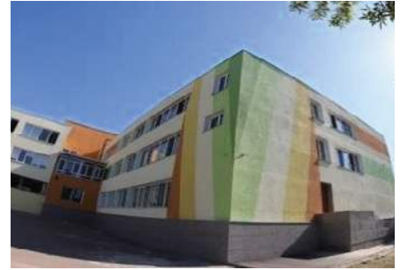
Малюнок 18. Після реконструкції
