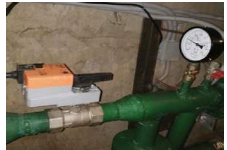
Малюнок 38. Регулятор температури Belimo
