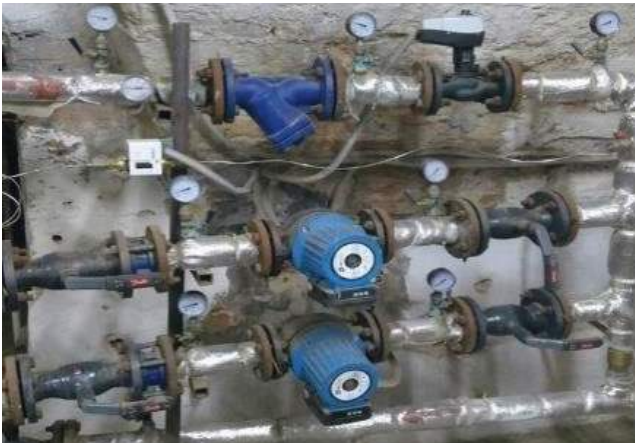
Малюнок 2. Вузол регулювання теплоносія
