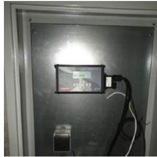
Малюнок 11. Тепловий лічильник Sempal
