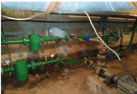
Малюнок 36. Система регулювання теплоносія та тепловий лічильник
