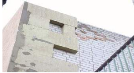
Малюнок 34. В процесі реконструкції
