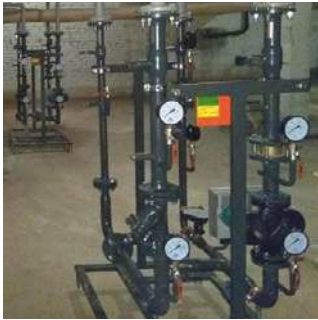
Малюнок 9. Модульні ІТП Danfoss №1, №2
