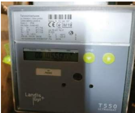
Малюнок 19. Тепловий лічильник Ultraheat
