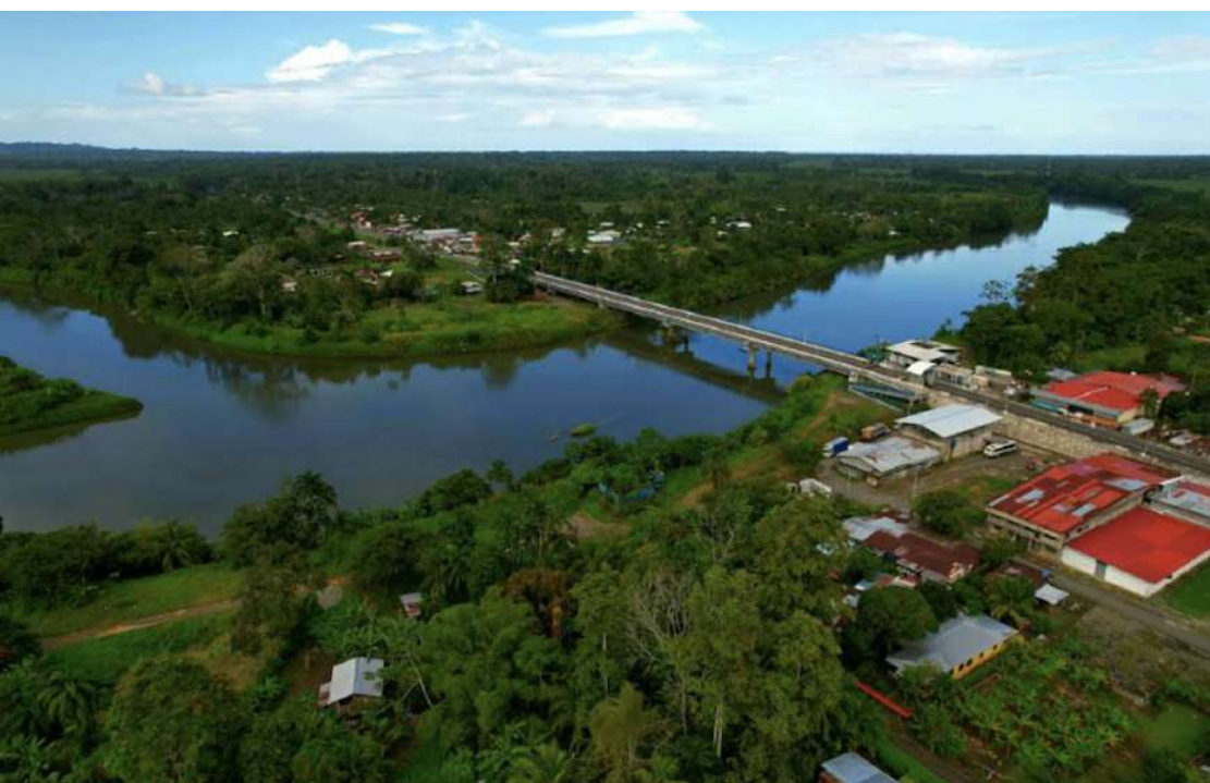
Fotografía 7. Vista del puente sobre el río Sixaola, paso fronterizo entre Costa Rica y Panamá, noviembre de 2022.
