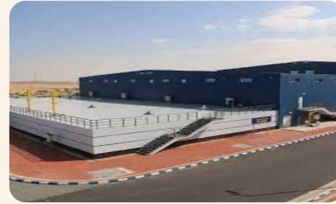
محطة تحلية مياه البحر بالشرق
