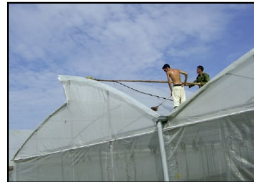
Método de la escoba para limpiar el techo.
