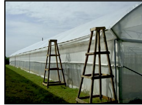
Andamios para facilitar la limpieza de los techos.
