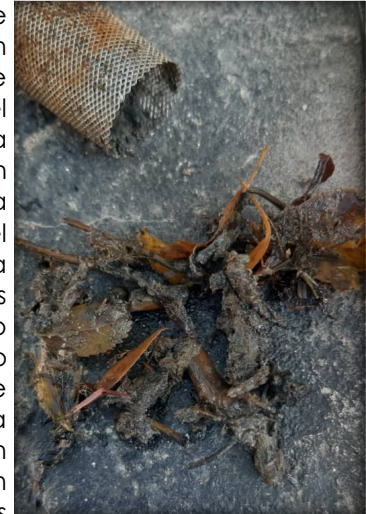
Filtros de agua sucios
