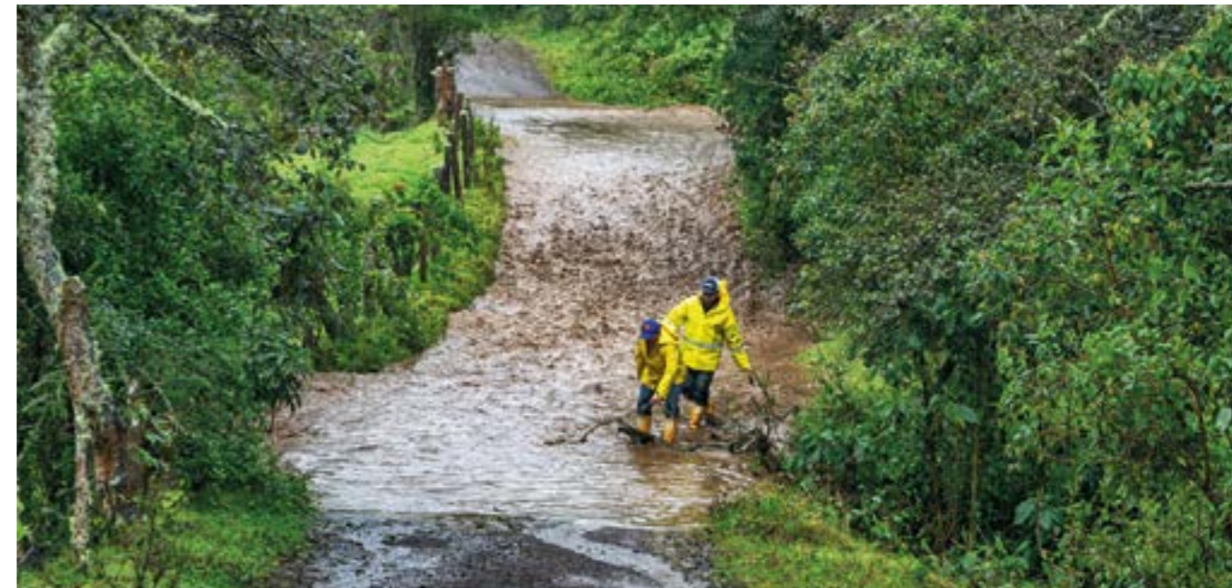
Desbordamiento del río Tomiguina debido a lluvias intensas, parroquia de Papallacta, cantón Quijos, provincia de Napo – Proyecto AICCA
