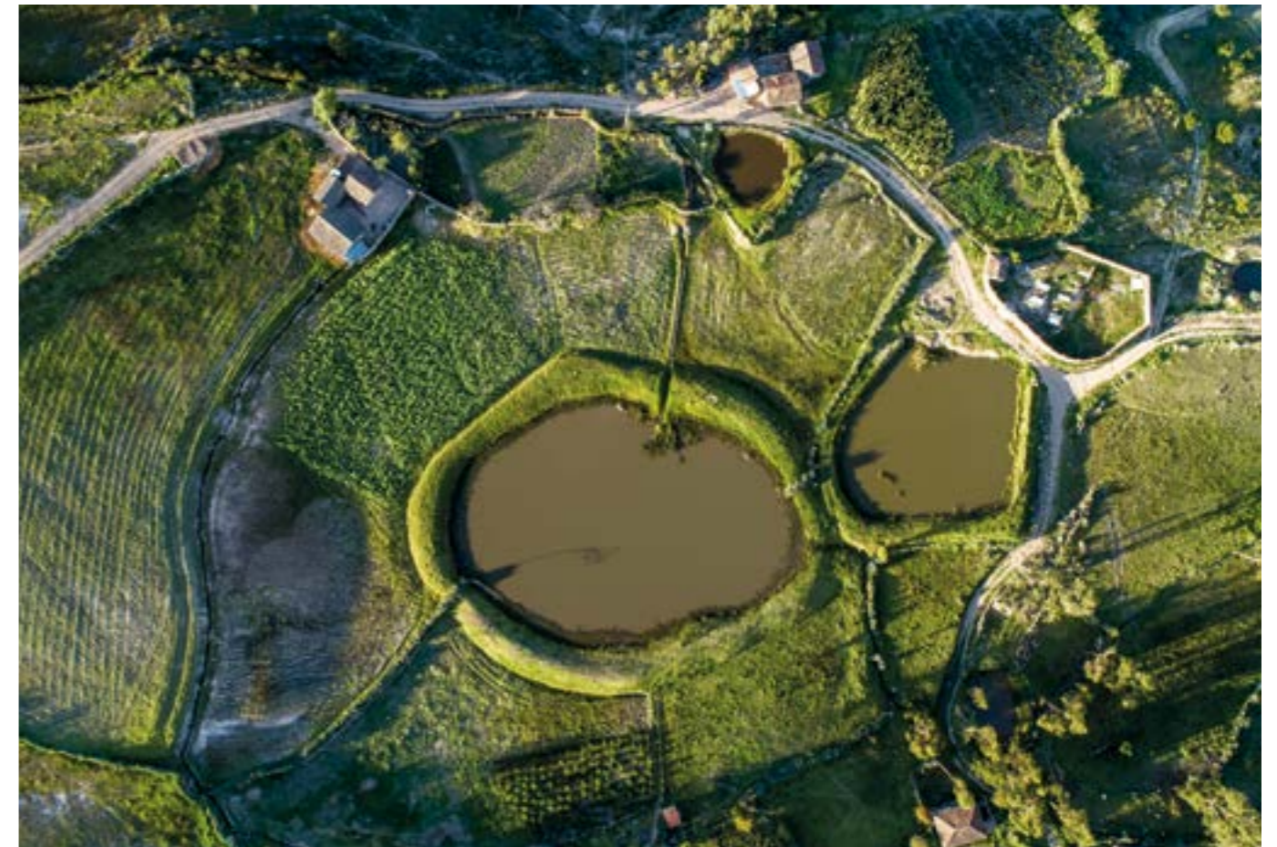
Medida de Adaptación de reservorio de agua, cuenca del Río Jubones – Proyecto FORECCSA
